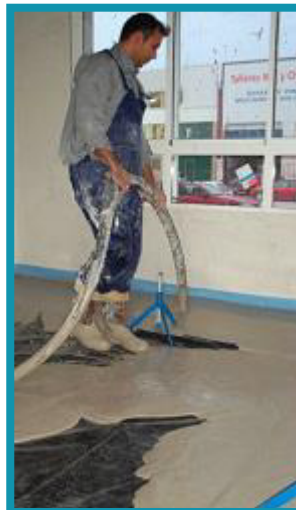
Placing Screed Gyvlon
